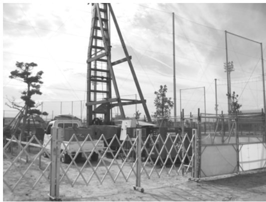
清流スタジアム北側で工事が進んでいる「健幸の泉」は憩いの施設だが災害時には非常水源となる
